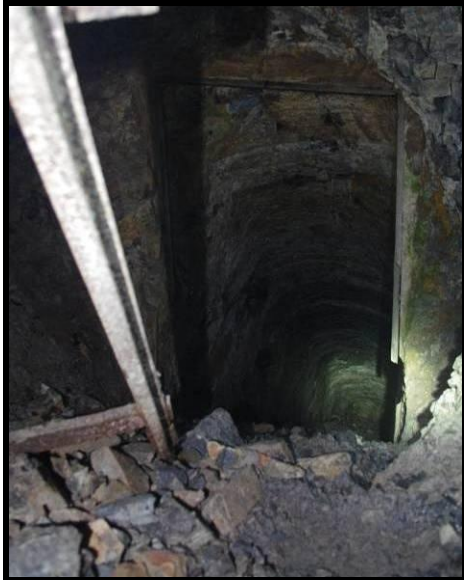
Photographie 6 : Vue de la descenderie [2] depuis la carrière de pierre à ciment (un rail est visible au premier plan)
