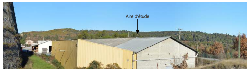
Photo 16 - Depuis le pont de l'ancienne voie ferrée de Valdonne
