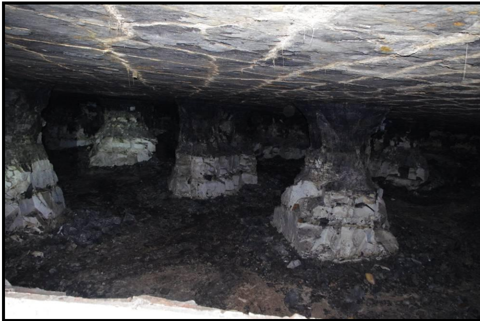
Photographies 8 : Vues des zones exploitées sur une grande hauteur (4 m)
