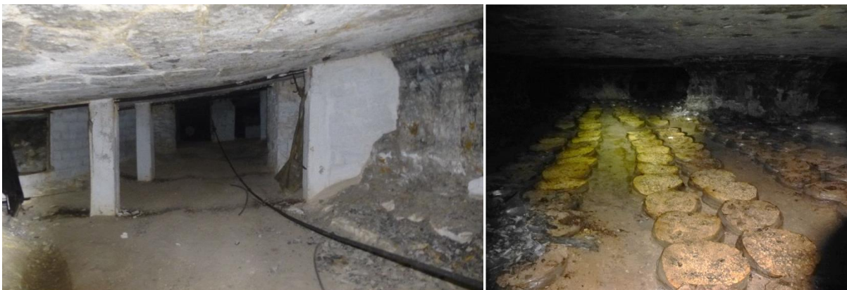
Figure 7 : Aperçu du volume souterrain (à gauche) et vestige de l'ancienne champignonnière (à droite)
