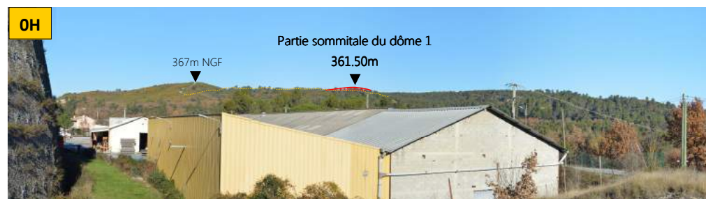
Depuis le pont de l'ancienne voie ferrée de Valdonne
